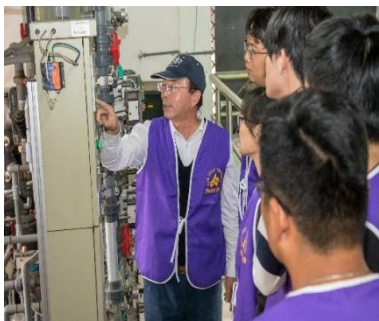
本校污水處理廠/建置雙薄膜中水回收處理系統。
